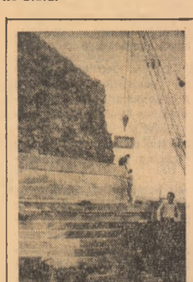
Continuă în ritm susținut restaurarea celui mai grandios monument de pe teritoriul traco-dacic și al lumii romane. În diametrul de 40 de metri, egal cu înălțimea, monumentul de la Adamclisi, dominat de statuia zeului Marte, va fi, fără îndoială, un punct de mare atracție turistică. În fază avansată se găsește și restaurarea cetății din apropiere, care, în urmă cu două milenii, era portul unul din brațele Dunării.
