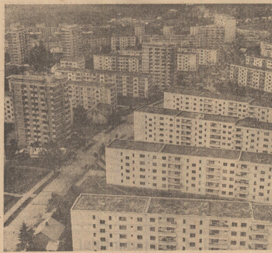
Construcții noi în municipiul Suceava
