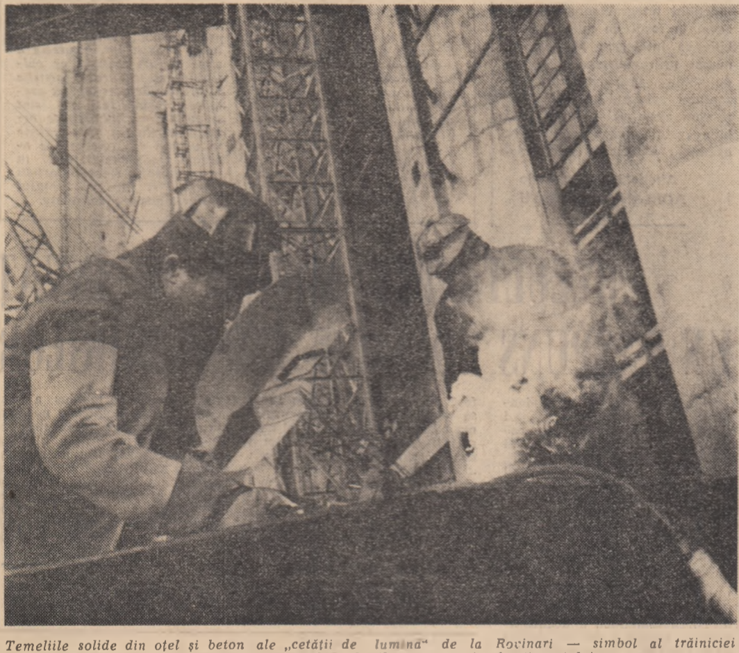
Temeliile solide din oțel și beton ale „cetății de lumină” de la Rociinari — simbol al trăiniciei faptelor de muncă ale brigadierilor pe șantierele tineretului.
