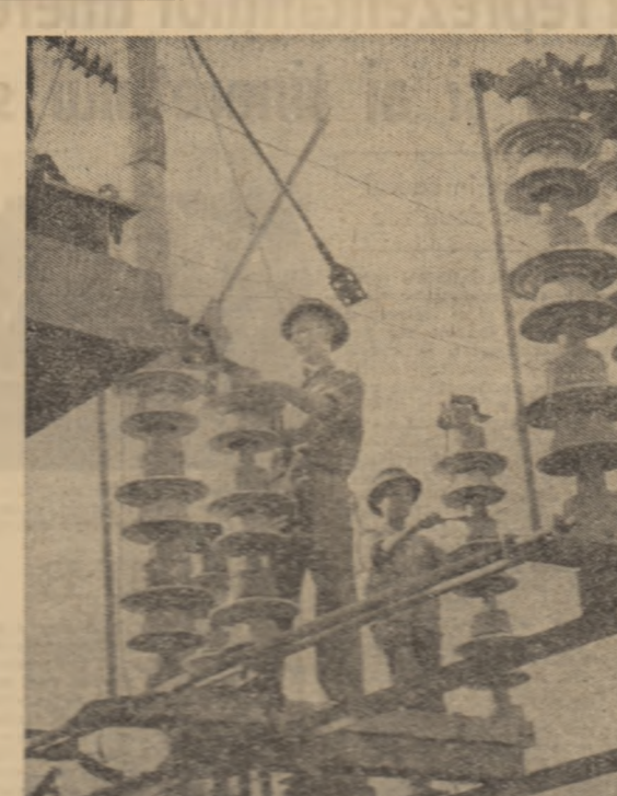
În Republica Socialistă Vietnam se depun eforturi susținute pentru electrificarea unor noi regiuni de țară. În fotografie: Aspect din timpul lucrărilor de montare a unei stații de transformare electrică.
