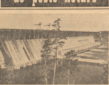
U.R.S.S. Imagine o barajului marei hidrocentrale electrice Brazil de pe Angoro
