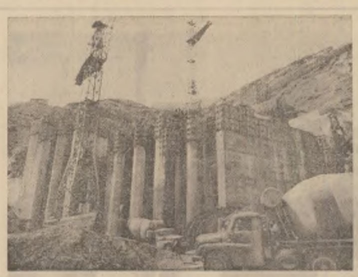
Imagine a șantierului hidrocentralei din Fierze, aflată în construcție în nordul Albaniei. Ea va livra 1,7 miliarde de kW/h energie electrică pe an.
