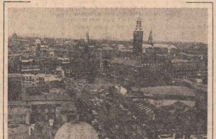
Vedere din Copenhaga.
