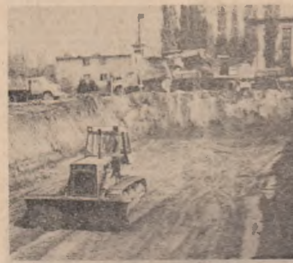
Front de lucru pentru noua blocuri de locuințe din Zimnicea. Foto: GH. CUCU
