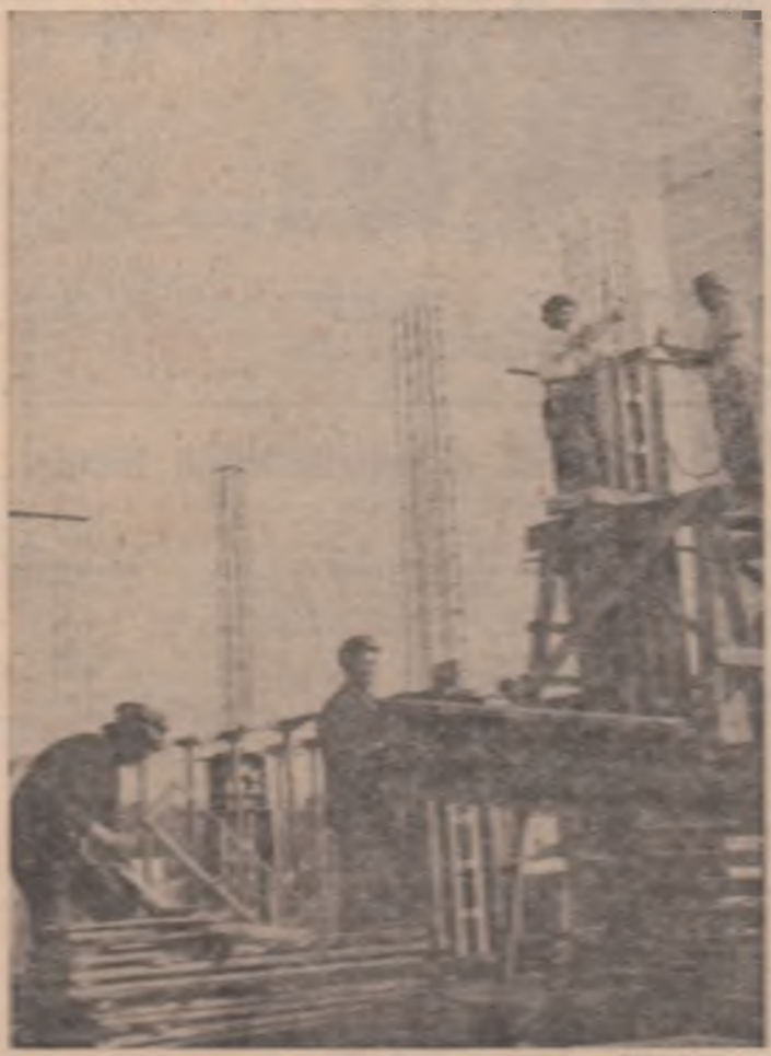
Ca pe țara aproape totul, și în construcții, sunt în desfășurare lucrările de finalizare a șantierului pentru a realiza în termen planificat și să se realizeze în condiții de siguranță și disciplină.
