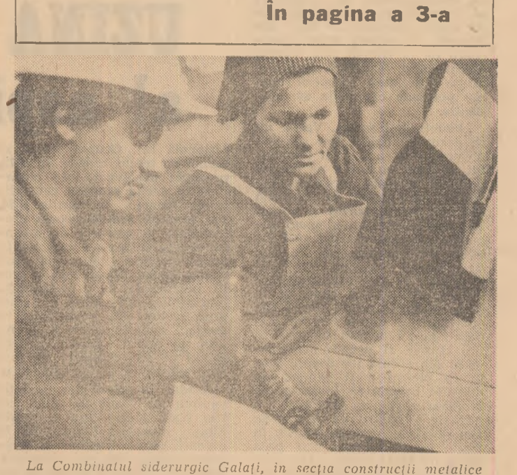
La Combinatul siderurgic Galați, în secția construcției metalice Foto: GHEORGHE CUCU
