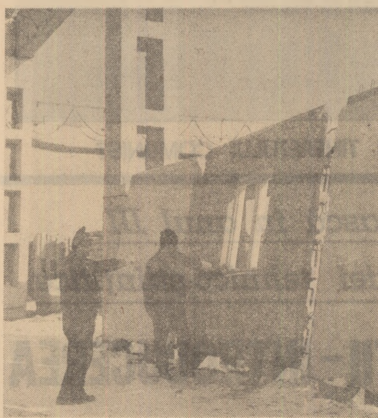
În baza de prefabricate a I.J.C.M. Sibiu se analizează noile propuneri de îmbunătățire a calității și esteticii panourilor pentru fațade
