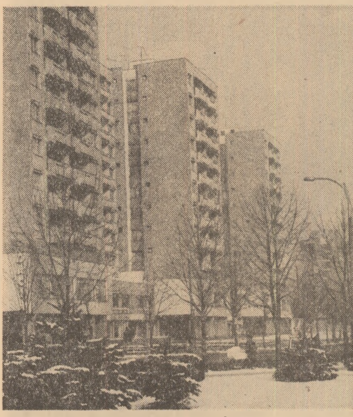
Construcții noi la Hunedoara Foto : O. PLECAN
