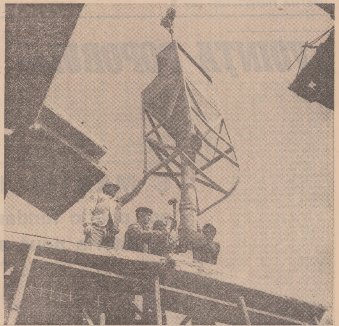
O nouă cupă cu beton fierbinte în temelia marelui oraș
