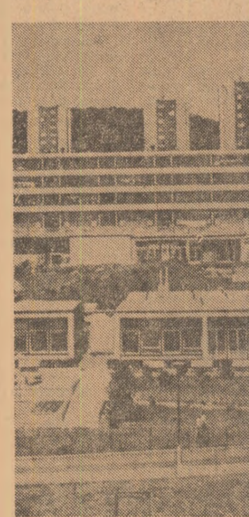
R. S. CEHOSLOVACĂ. Construcții noi la Bratislava
