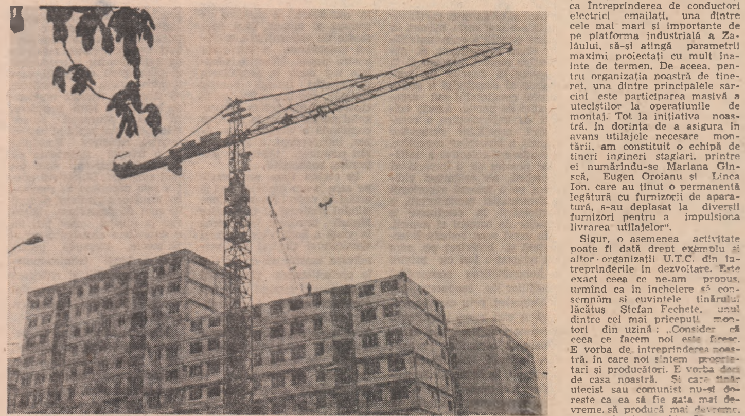
Drobeta-Turnu Severin. Construcții de locuințe spre cota finală. Foto: VALERIU TANASOF
