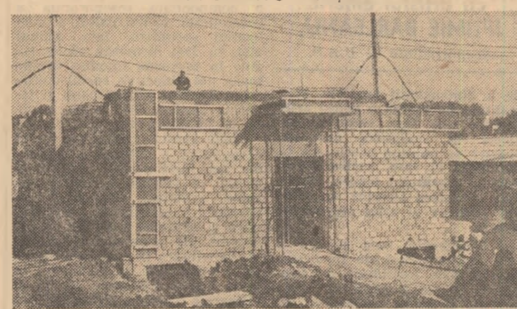
Stația de transformare urcă în ritm de melc spre nivelul doi, o cotă care ar fi trebuit să fie atinsă demult
