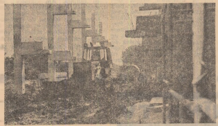
Pe locul unde ar fi trebuit să fie laboratoarele, excavatiile sînt încă „la zi”.
