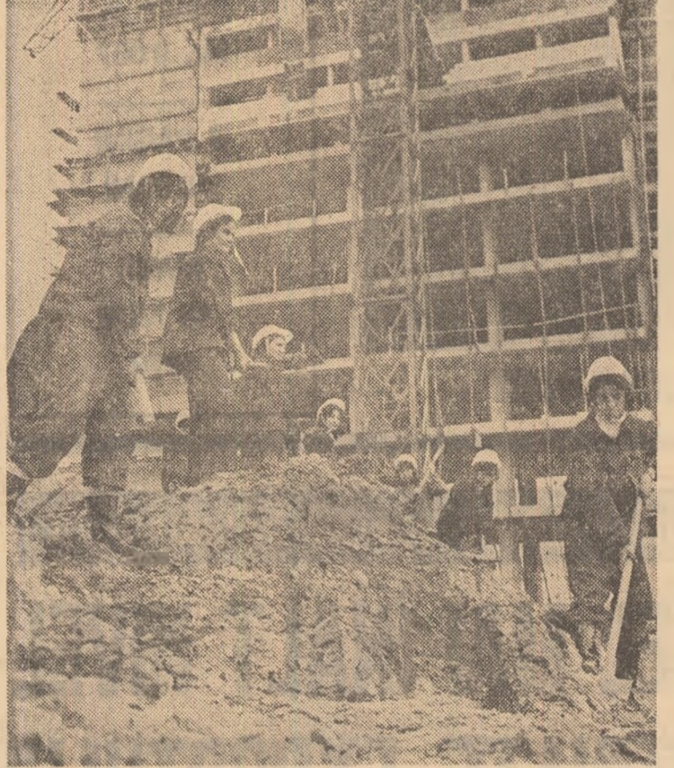
Eleve din anul III al Liceului industrial din Rm. Vilcea, muncind pe Șantierul „Casel științei și tehnicii”
