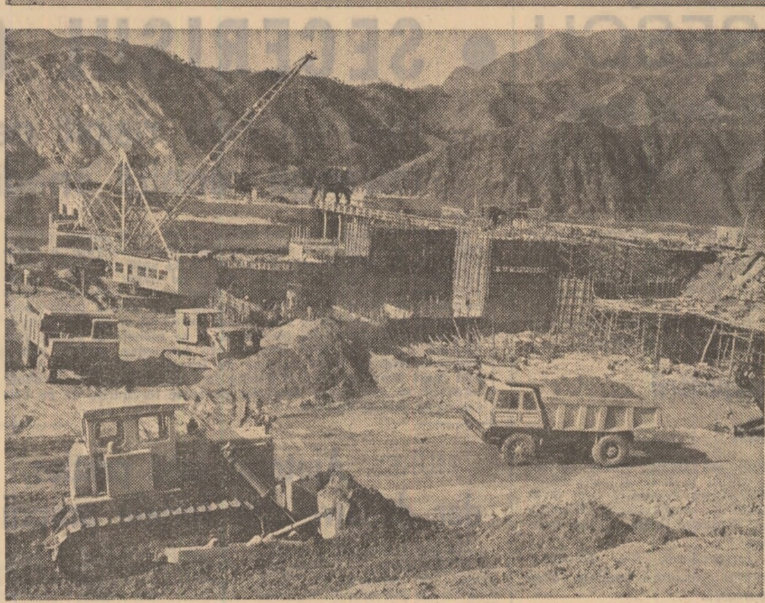
R. P. CHINEZĂ. Imagine de pe șantierul hidrocentralei din zona fluviului Luanho, provincia Hopei
