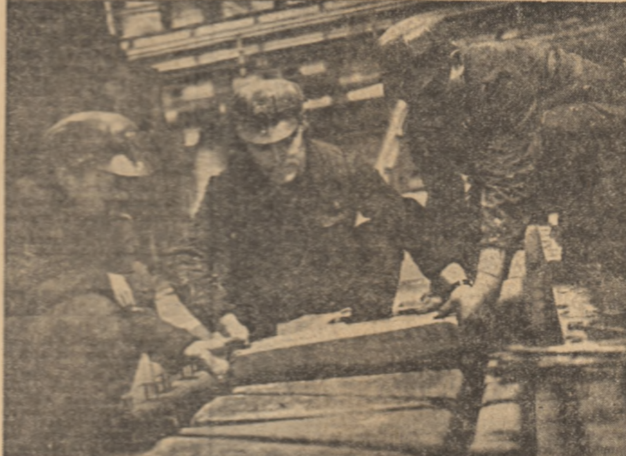
În atelierul de montaj al șantierului de construcție navală din Galați. Foto: V. TANASOF
