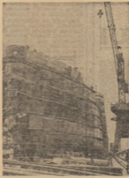
În atelierul de montaj al șantierului de construcție navală din Galați.
