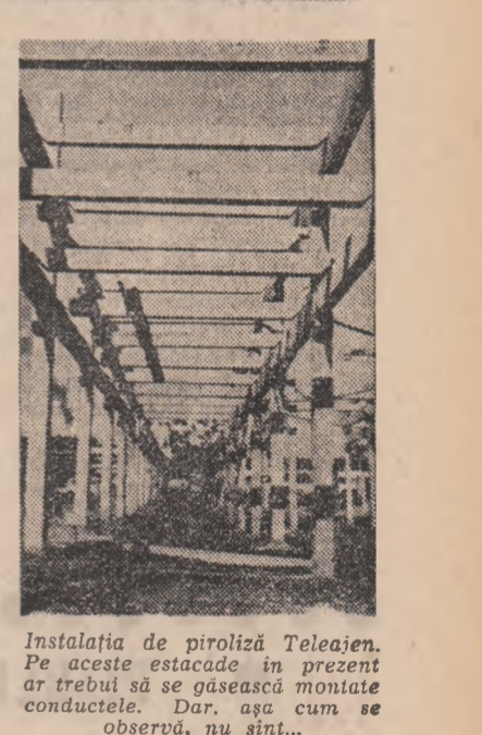
Instalația de piroliză Teleajen. Pe aceste etacade în prezent ar trebui să se găsească montajele conductelor. Dar, așa cum se observă, nu sînt...
