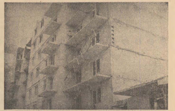
Cadrelor metalice pentru balcoane se ridică pînă la etajul al IV-lea cu... jîrnghia. Lipsesc cumva, pe șantier, mijloacele mecanice?
