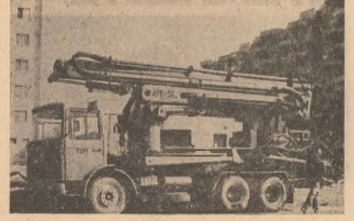
O autopompă pentru beton, utilaj de mare productivitate, sta garată pe „dreapta“, în timp ce, în plin program, constructorii își văd liniștiți de vorbă
