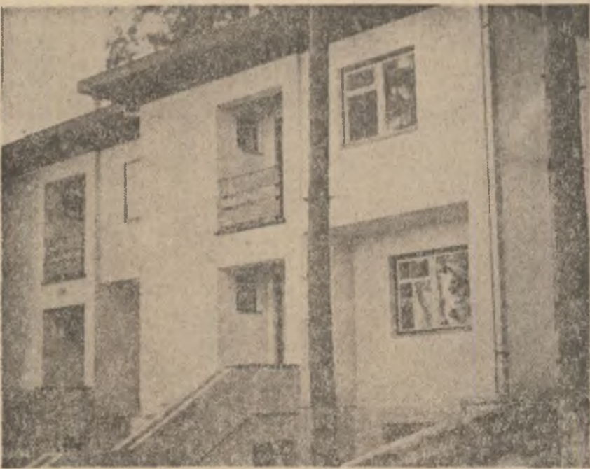
Printre locuințele viitorului se află și acest frumos duplex construit la poalele Timpei, din elemente spațiale tip inel
