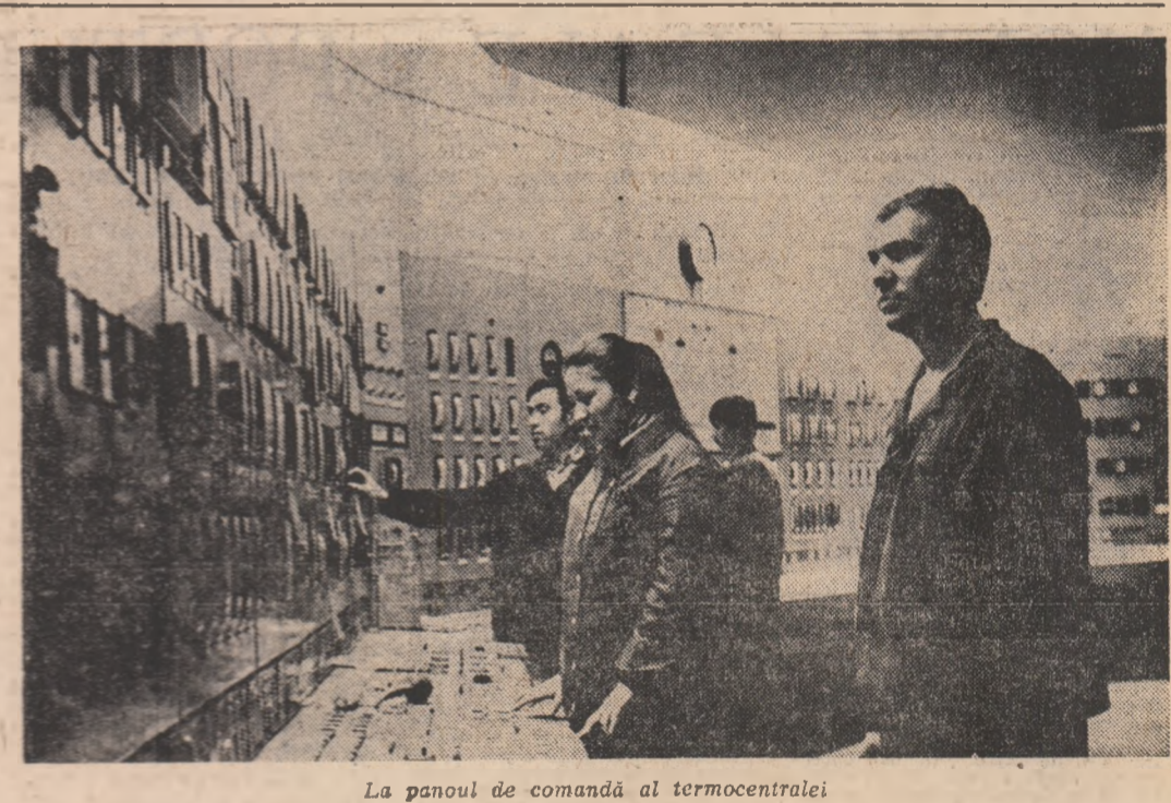
La panoul de comandă al termocentralei
