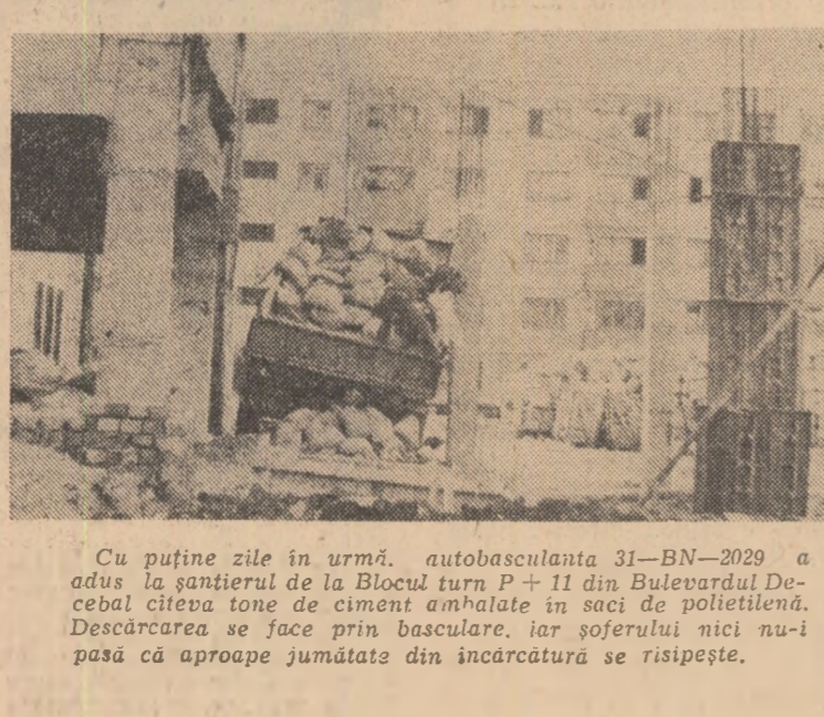
Cu puține zile în urmă, autobasculanta 31—BN—2029 a adus la șantierul de la Blocul turn P + 11 din Bulevardul Decebal cîteva tone de ciment ambalate în saci de polietilenă. Descărcarea se face prin basculare, iar soferului nici nu-i pasă că aproape jumătate din încărcătura se risipește.
