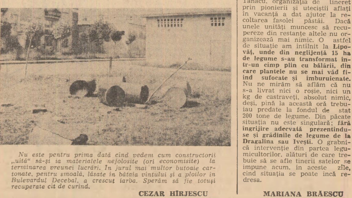
Nu este pentru prima dată cînd vedem cum constructorii „uită” să-și ia materialele nefolosite (ori economisite) la terminarea vreunei lucrări. În jurul mai multor butoaie cartonate, pentru smolă, lăsate în bătaia vîntului și a ploilor în Bulevardul Decebal, a crescut iarba. Sperăm să fie totuși recuperate cit de curînd.
