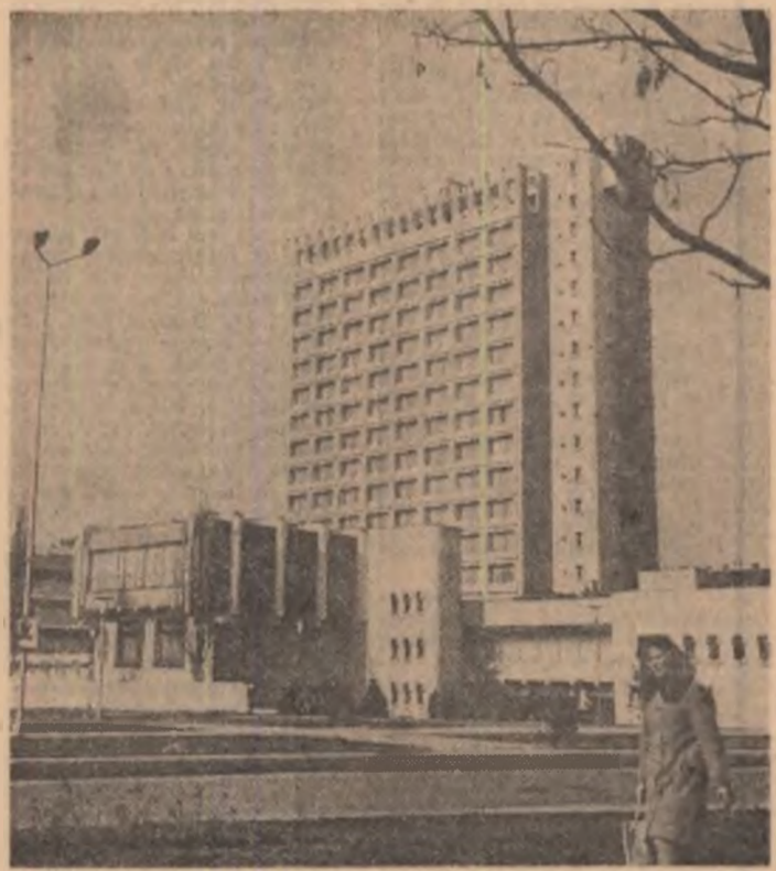
O construcție modernă, noul hotel „Continental” din Timișoara
