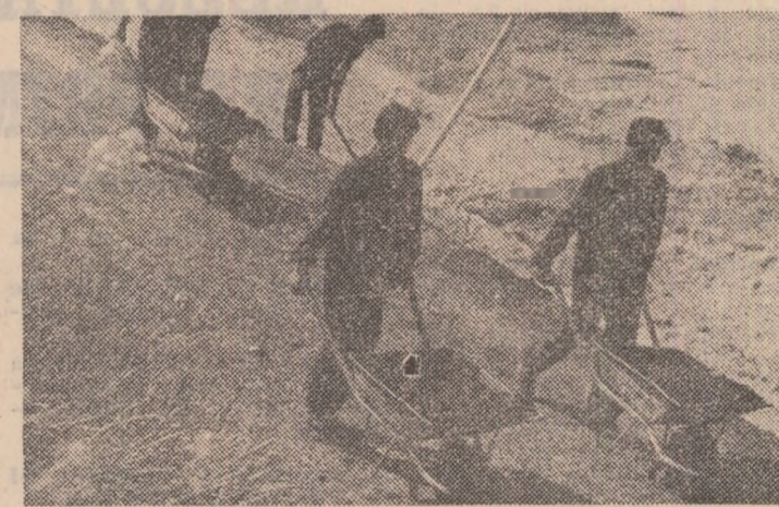
cațărăți pe frînghie, despre soarele nemilos sau ploile ce odată pornite par a nu se mai opri, despre carioaje, fascine, soluii tehnice, excavatoare, buldozere. Studenții anului II Hidrotehnică, lași, viitori specialiști în astfel de lucrări, știu foarte bine ce înseamnă o astfel de realizare. Știu ce înseamnă și cum se face. Și totuși, iată, o ambiție născută aici îl face să ne spună — cu un același orgoliu ce-l conduse pe un om să se semneze pe o pilă de pod: Vasilică, Boțoșani, 1977 — că ar fi dorit să lătureze singuri într-o porțiune, oriunde, la carioaj, la betonare, la excavații. Așa, zic, ei, ar fi
