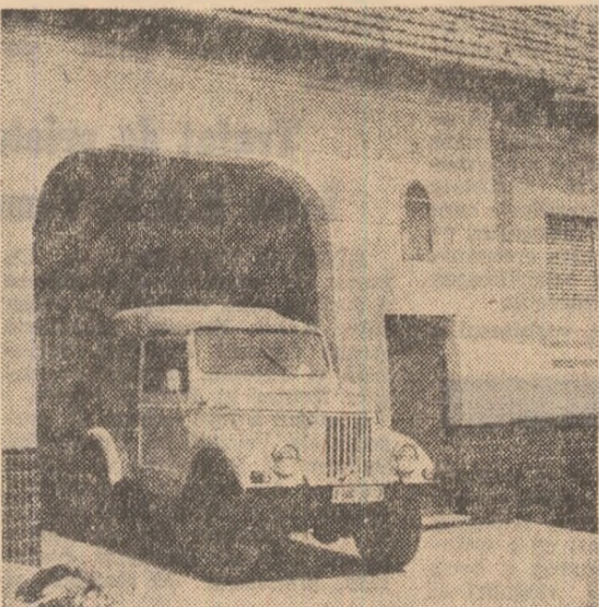
În sat nu sînt prea multe familii. Rostul lor este acum pe munte sau în cîmp. Cei care au rămas au treburi importante. De exemplu construiesc. Să facem un calcul: o casă cum este cea din imagine are termen de garanție de cel puțin 100 de ani. Și se construiesc anual în jur de 40 de astfel de edificii. Costă în jur de jumătate de milion.
