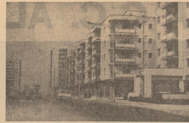
Zestrea edilitară a municipiului Vaslui se îmbogățește cu noi blocuri de locuințe cum sînt și acestea din imagini, situate pe ambele părți ale străzii Ștefan cel Mare.
