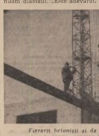
Fierariști betonisti și de ocazată dată la... înălțime
