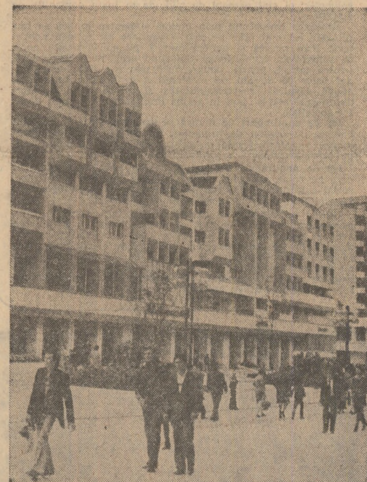
Not construcții la Craiova
