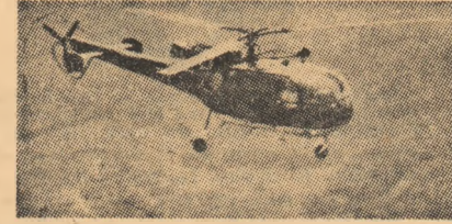
I.A.R.-316 B Alouette III, elicopter reactiv ușor, viteza de croazieră 185 km/h, viteza maximă 210 km/h, plafon practic 3 200 m, încărcătură utilă 1 143 kg
