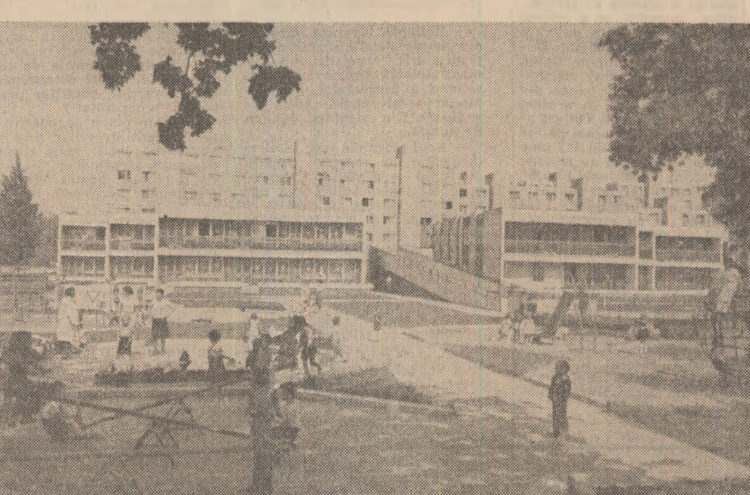
R. S. CEHOSLOVACĂ — Noi siluete arhitecturale într-unul din cartierele orașului Bratislava
