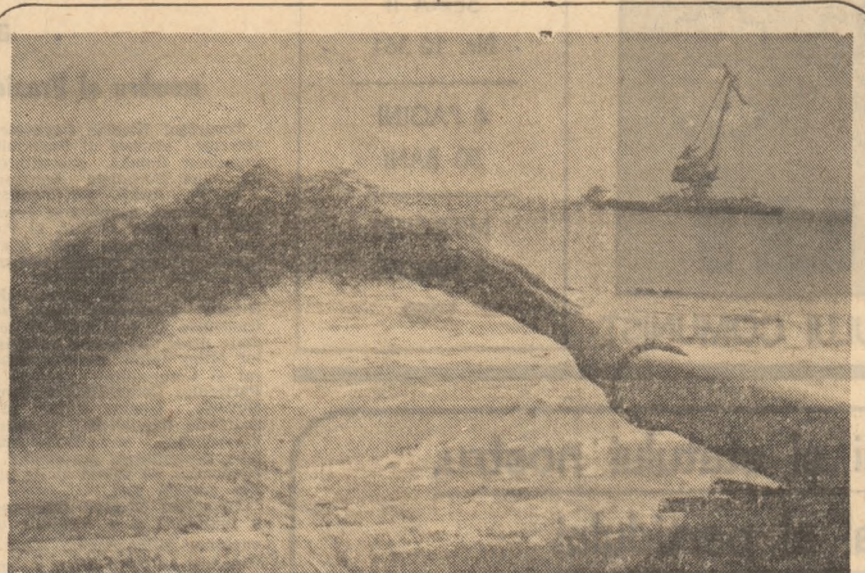
In aceste zile, pe plaja de la Mamaia, în apropierea Teatrului de vară, prin conducta montată pe lacul Stutghiol este adus nisplul. În planul secund se lucrează la amenajarea unui dig protector.
