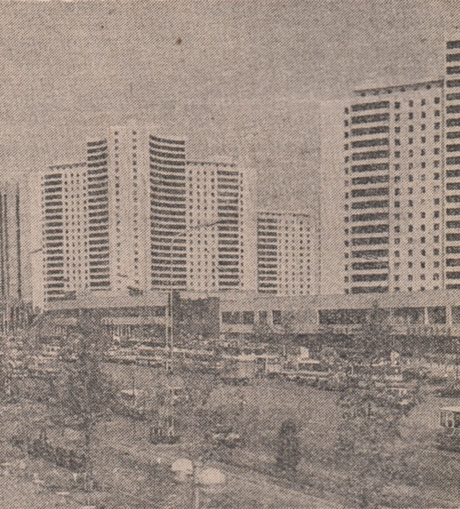
R.P.D. COREEANĂ : Construcții noi, moderne în noul cartier Kwangkong din capitala țării, Phenon
