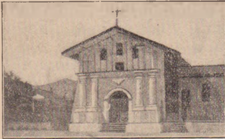
Mistunea Dolores construită de Franciscar. la 1778
