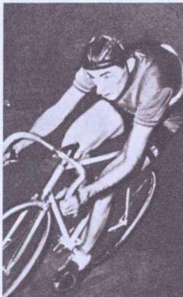
1942. Fausto Coppi îl detronează pe Archambaud din fruntea listei recordmanilor orei.
