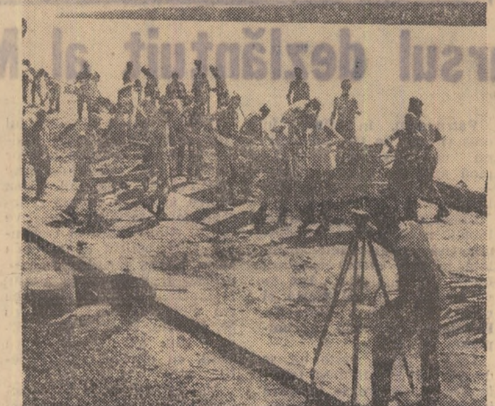
Muncă neobosită, însuflețită, pentru consolidarea zidului de protecție a terenurilor aparținind I.A.S. Bădălan. Încă o pagină de eroism în lupta crinencă cu apele!
