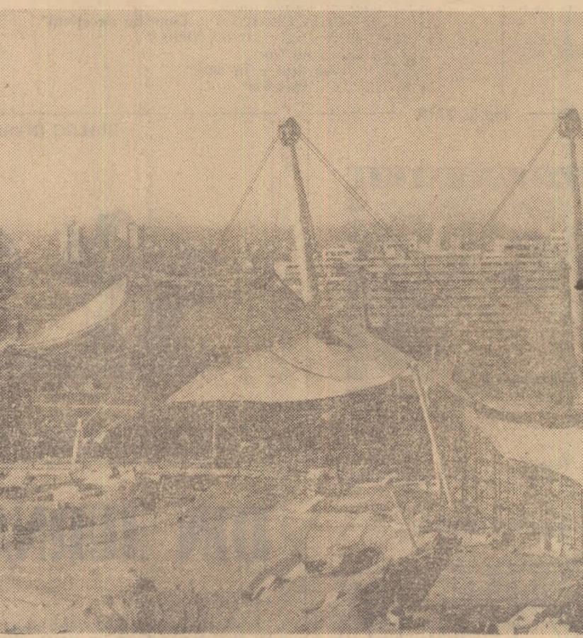
O parte din instalațiile sportive care vor beneficia de uriașul acoperiș translucid (în prim-plan piscina olimpică, în fundal: Satul olimpic)
