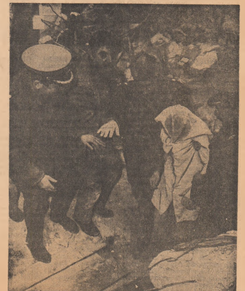
După 65 de ore de întinerie, în ruinele blocului de la cofetăria „Scala”, Floarea Iordache vede lumina zilei.
