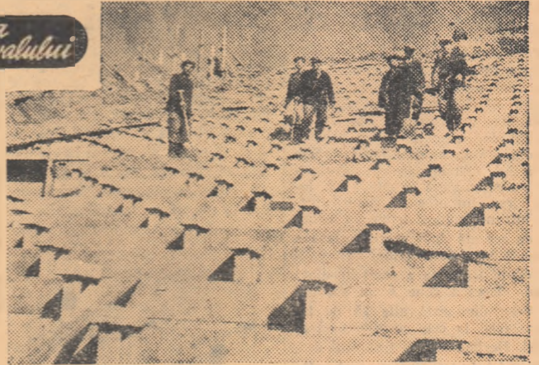
Se montează gradenele tribunelor noului stadion din Varșovia.
