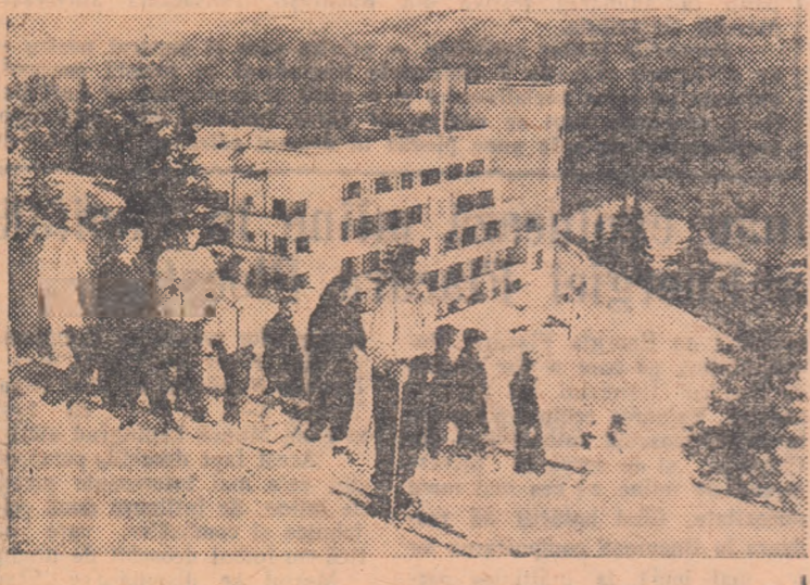
În curînd, astfel de aspecte vor putea fi întîlnite la tot pasul, nu numai la 1400 m. deasupra nivelului mării. Dar, sezonul sportiv de iarnă nu trebuie așteptat, ci pregătit...
