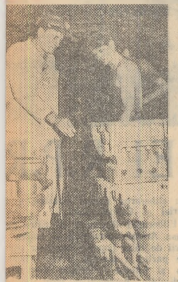
El turnat un nou lot de blocuri u motoare. Maistrul Nicolae A- supraveghează atent curățirea isarea lor.
