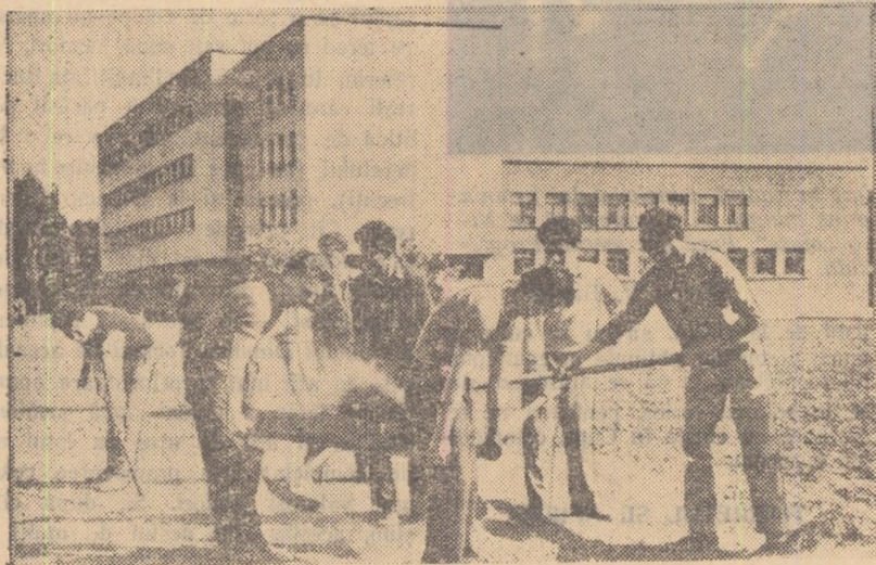
În orele libere viitorii ingineri constructori muncesc cu multă trageră de inimă pentru amenajarea micului lor stadion.
