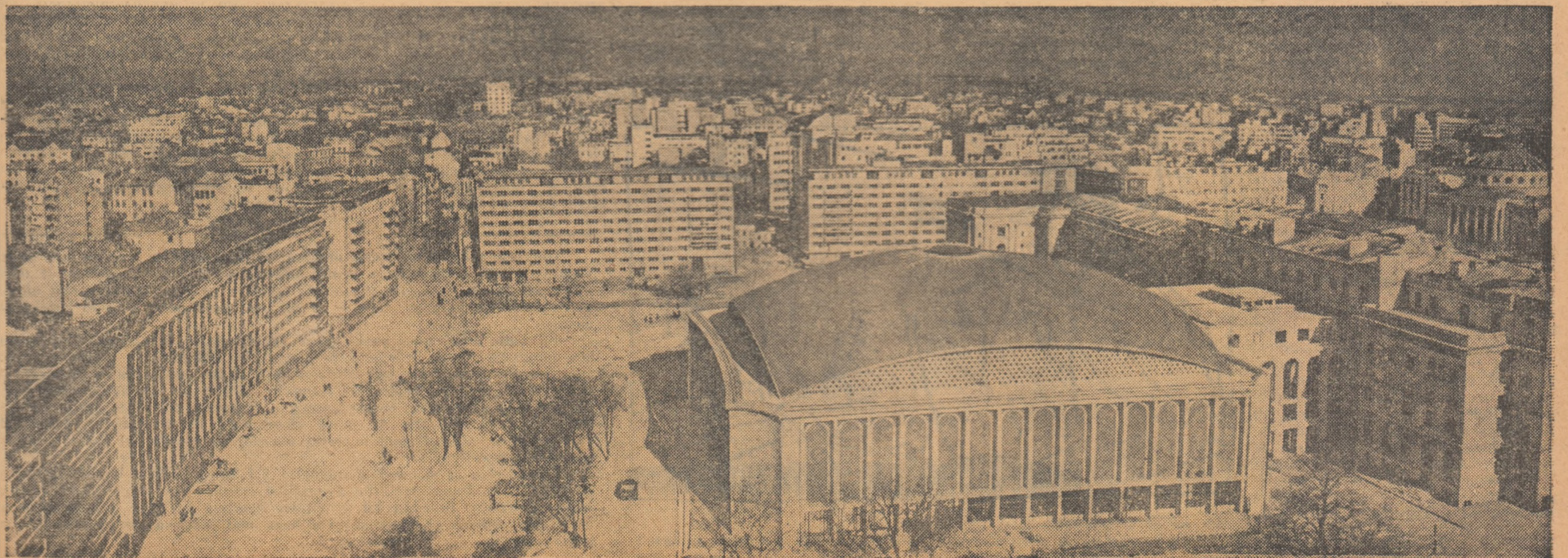
Vedere generală a noilor construcții din Piața Republicii.
