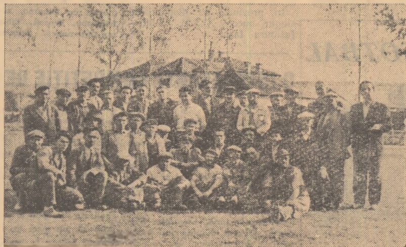
Un grup de harnici sticlari care s-au evidențiat la construirea terenului din Tirnăveni. Foto: I. Hășașiu
