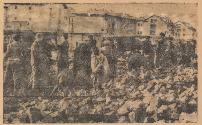
A început „Luna construcțiilor sportive”. Chiar de la start — duminică — această acțiune s-a bucurat de mult entuziasm. În raionul „1 Mai” din Capitală, de pildă, sportivii au început amenajarea complexelor I „Barbu Văcărescu” și IV „Electronica”. Iată un instantaneu de pe șantierul primului complex, unde, ieri după-amiază, tinerii muncitori de la I.T.B. ajutați de cei vîrstnici, au continuat lucrările de deblocare ale viitoarelor terenuri. În curînd cartierul Floreasca va deveni și mai frumos prin aceste noi baze sportive, pe care se va întrece tineretul în soare, aer și lumină.
