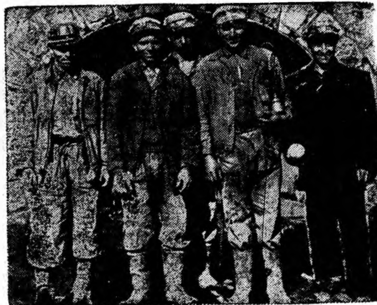
Rezistență la presiunea rocilor, durată de folosire de zeci de ani, iată cîteva din principalele condiții ce le îndeplinesc galeriile de la mina Vulcan pe care le betonează brigada de pregătire condusă de minerul Ionașcu Ioan din sectorul VIII investiții. Membrii brigăzii întîmpină Ziua minerului și ziua de 23 August cu frumoase depășiri de plan la lucrările de betonare. ÎN CLIȘEU: Un schimb din brigada tov. Ionașcu Ioan (al patrulea din stînga).
