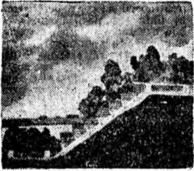
La Moscova s-a construit o galerie de escalatoare de suprafață. Cele trei benzi mobile ale scării, cu o lungime totală de 210 metri, sunt destinate să transporte un mare număr de oameni de pe malurile râului Moscova pe șoseaua Vorobievski. Escalatoarele sunt montate într-un tunel de sticlă, cu terase, care duc la stația de metrou „Colinele lui Lenin”.
