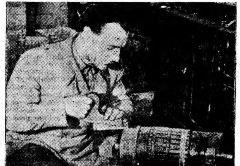
Electricianul Mogos Gheorghe se numără printre muncitorii frunțași ai secției electrice de la sectorul VIII al minei Petrila. Lucrînd la repararea motoarelor de 4,5 kW. pentru locomotivele electrice cu acumulatori tip L.A.M.-4, el a realizat în ultimul timp, o economie de 1236 lei.
